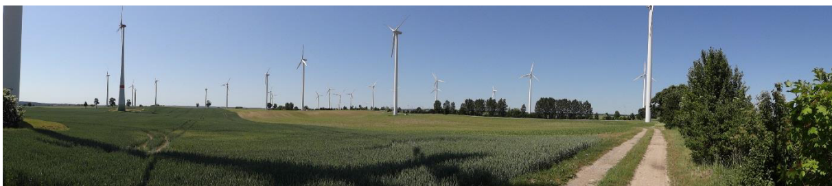
Abbildung 4: Blick über das bestehende Windfeld (von NO nach SW)
