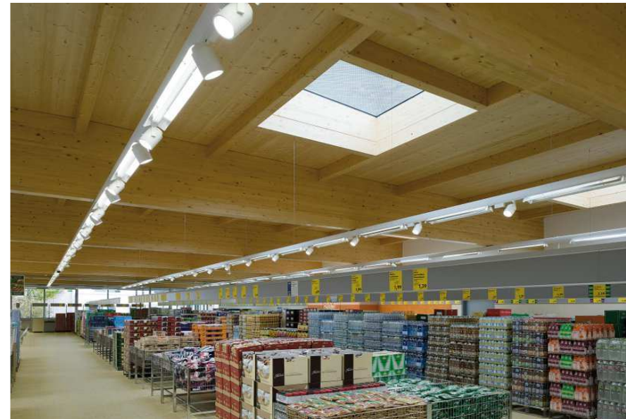
Abb. 97: Energiesparfiliale Aldi Süd in Raststatt mit Tageslichtnutzung 66
