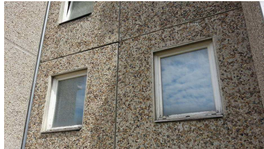
Abb. 37 bauzeitliche Fenster in den Wohnungen
