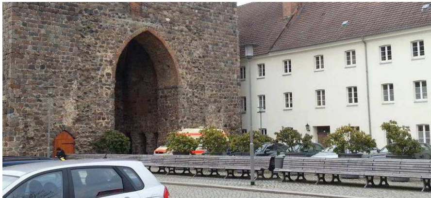
Abb. 10: Standort der Quecksilberdampfleuchten im Kaserneninnenhof
