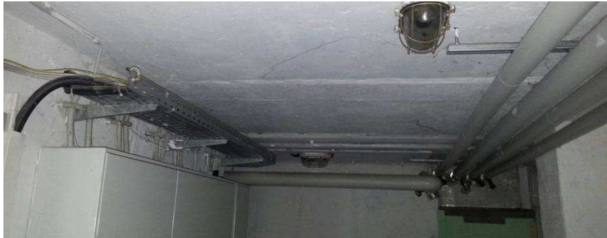
Abb. 41: ungedämmte Kellerdecke
