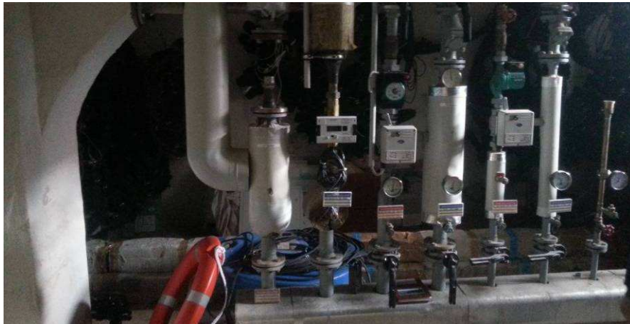
Abb. 73: fehlende Leitungsdämmstoffe
