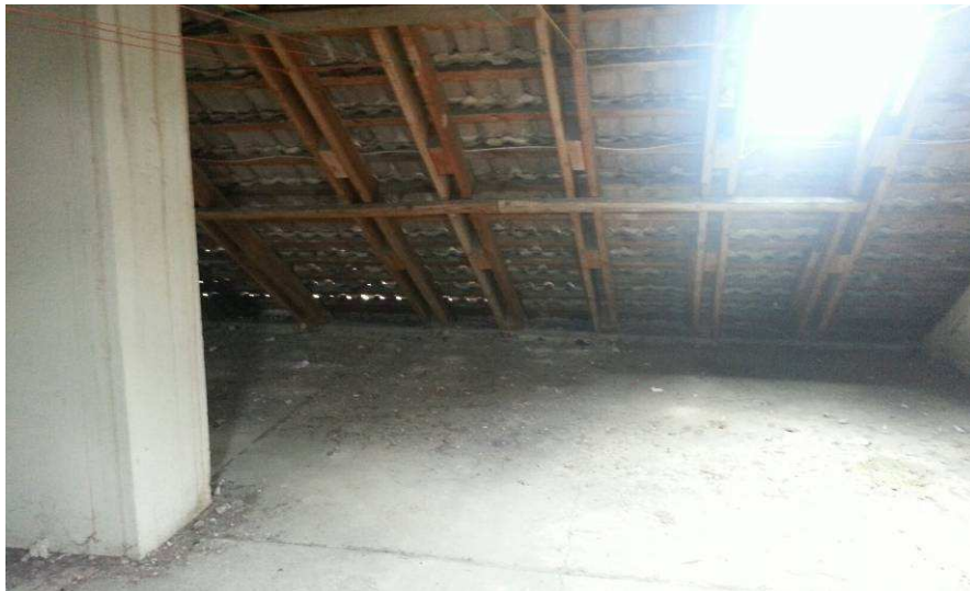
Abb. 43: ungedämmtes Dachgeschoss
