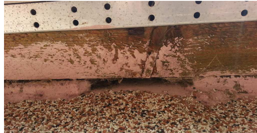
Abb. 50: Luftunterspülte Dämmung
