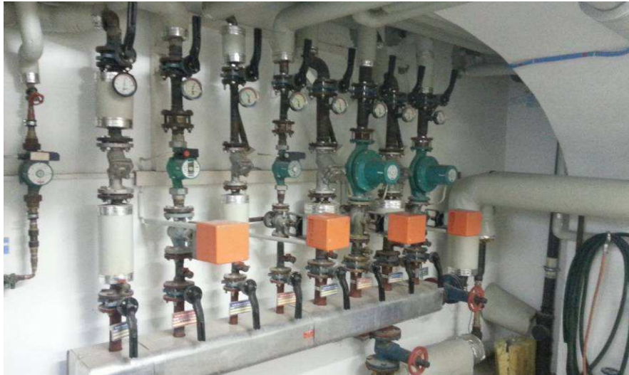
Abb. 78: fehlende Leitungsdämmung
