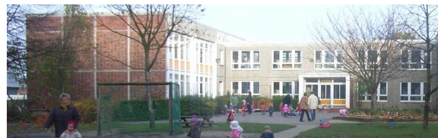
Abb. 105: Typ KK/KG vor der Sanierung Bildquelle: IGEL-Planung
