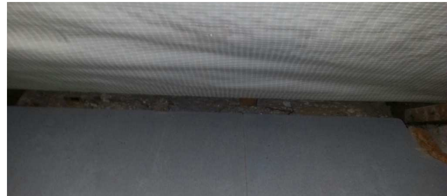
Abb. 51: ungedämmte Traufbereiche
