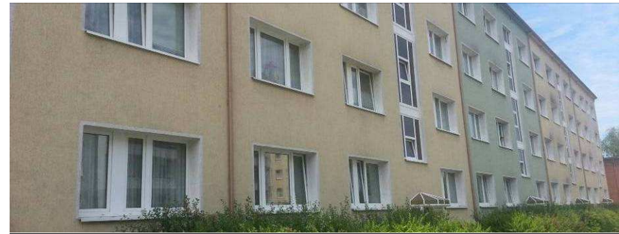
Abb. 40: Straßenansicht Wohnblock Straße des Friedens 2-10
