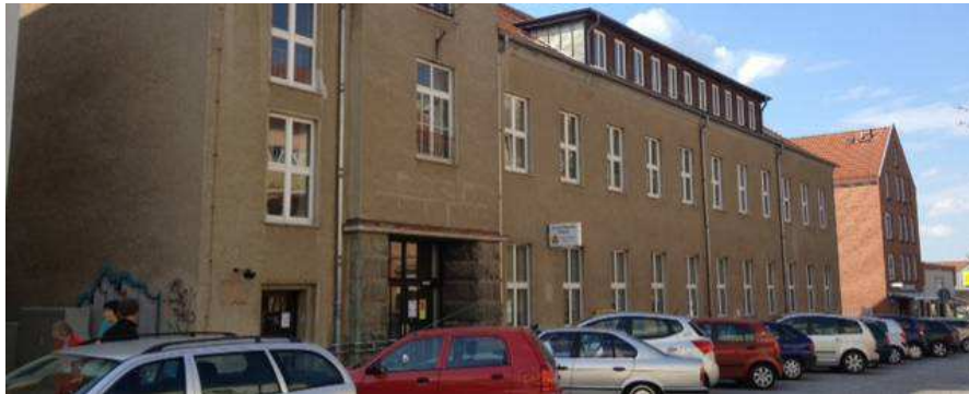
Abb. 19: Straßenansicht der ehemaligen Post
