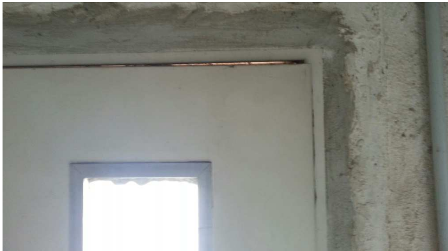
Abb. 52: Türundichtigkeiten
