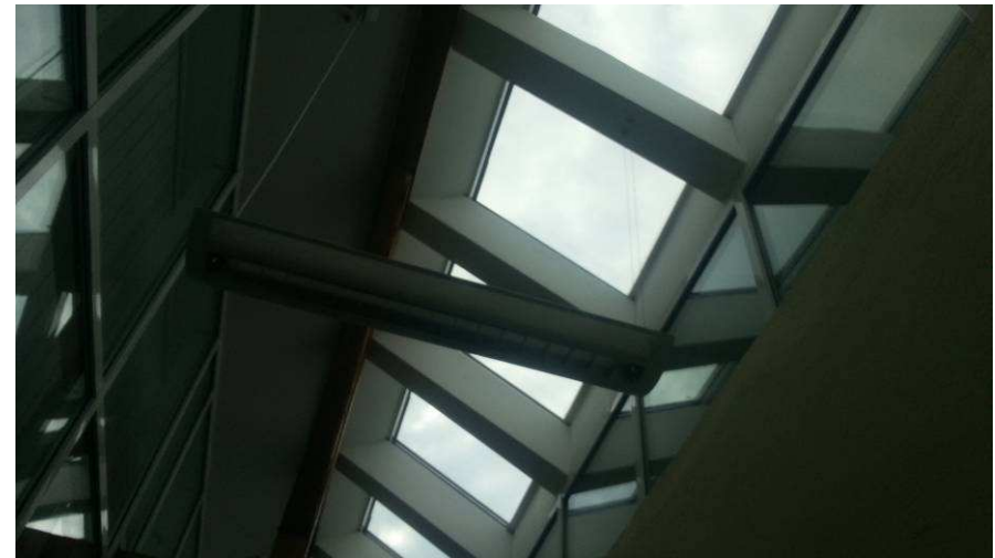
Abb. 70: Dachflächenfenster im Firstbereich
